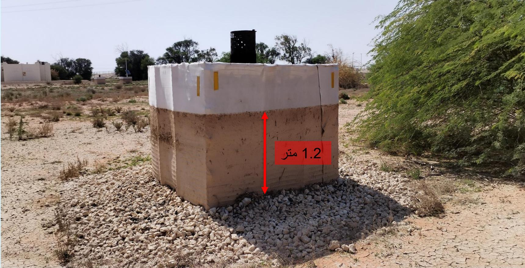
صورة تظهر مدى فاعلية آبار الحصاد المائي في نفاذ مياه الأمطار الى المستودعات الجوفية خلال وقت وجيز وتجنب تجمعها بكميات كبيرة لحماية المحطة الكهربائية.
